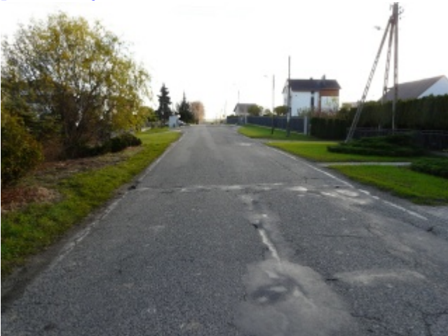
Kolejne dofinansowania do przebudowy dróg powiatowych - Borucin
