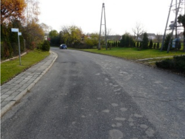
Kolejne dofinansowania do przebudowy dróg powiatowych - Kobyla
