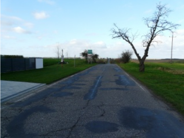
Kolejne dofinansowania do przebudowy dróg powiatowych - Borucin
