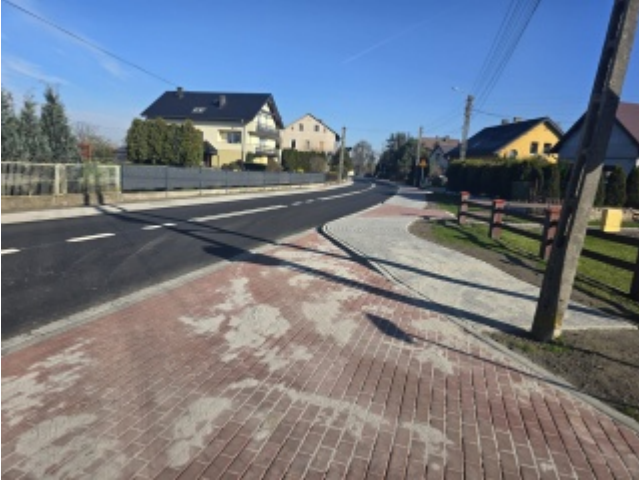
Nowa droga powiatowa w Turzu otwarta!
