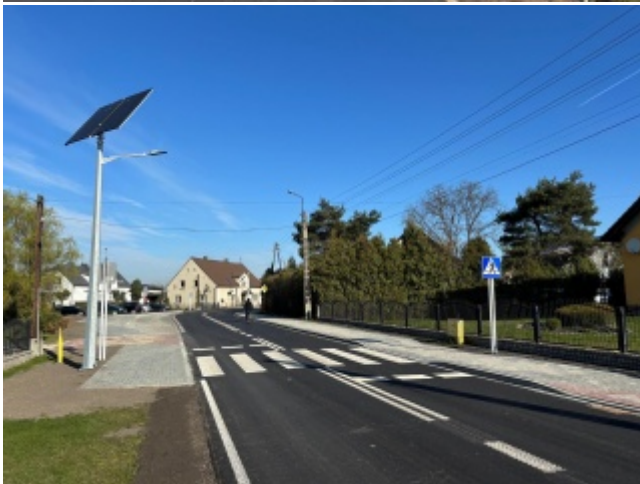
Nowa droga powiatowa w Turzu otwarta!
