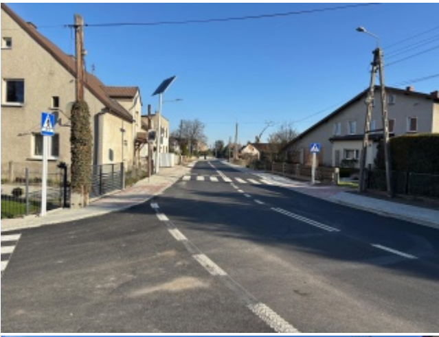
Nowa droga powiatowa w Turzu otwarta!
