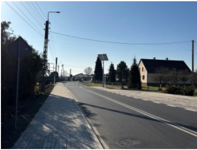
Nowa droga powiatowa w Turzu otwarta!
