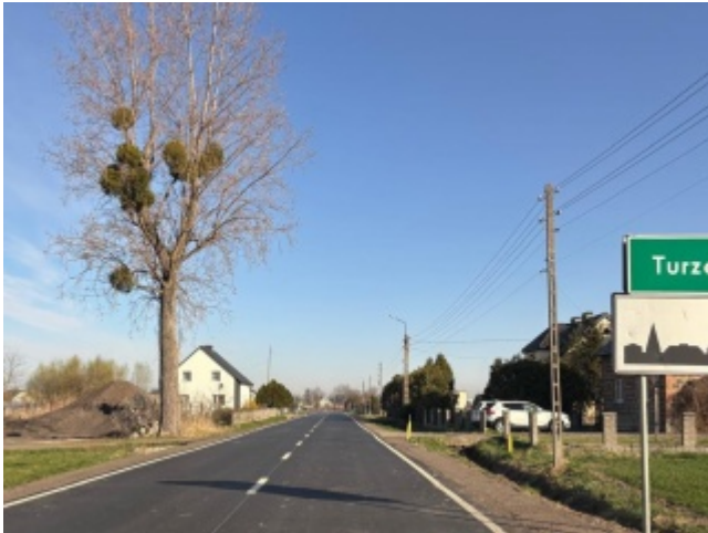
Nowa droga powiatowa w Turzu otwarta!
