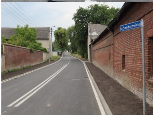
Otwarcie drogi powiatowej Krzanowice - Samborowice
