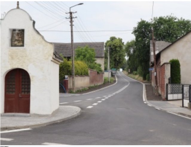
Otwarcie drogi powiatowej Krzanowice - Samborowice
