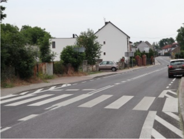
Otwarcie drogi powiatowej Krzanowice - Samborowice
