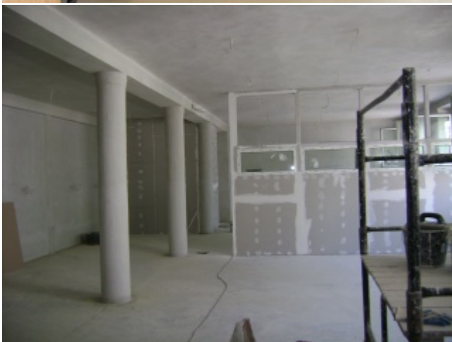
Pracownia automatyki w CKZiU2
