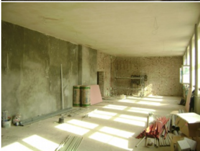
Pracownia murarsko-tynkarska w CKZiU1
