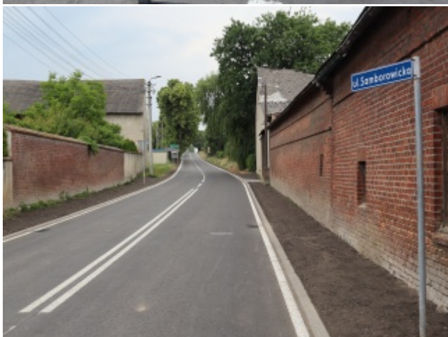
Otwarcie drogi powiatowej Krzanowice - Samborowice
